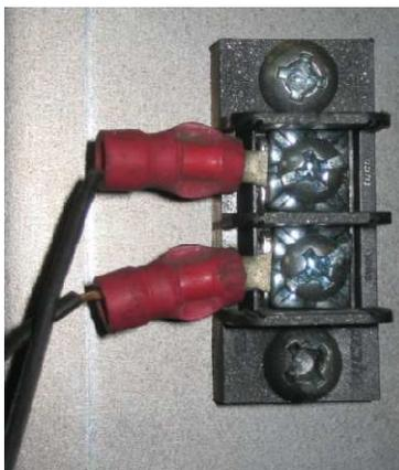
Voici un exemple de connexion au thermostat:
